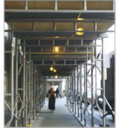
Şekil 37: İskele altı geçit
