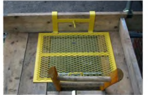
Şekil 23: Merdiven ulaşım açıklığı
