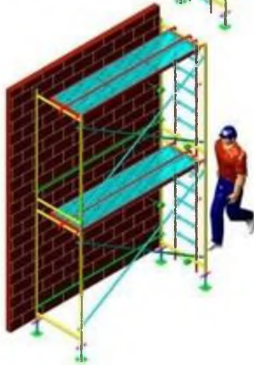
Üst Çaprazlar takılır
