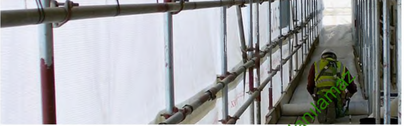
Şekil 40: İskelede kaplama yapılması
